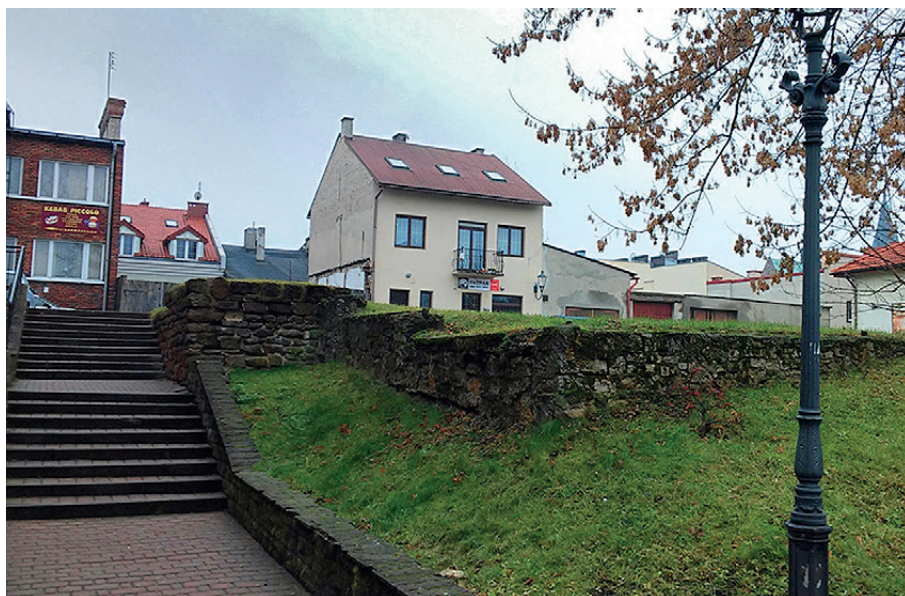
Ryc. 2. Olkusz, woj. małopolskie. Widok na plac pomiędzy ul. Górniczą i ul. Bóźniczą. Na zdjęciu widoczne jest na lewo czoło baszty (żydowskiej). Zgodnie z panującą w Olkuszu manierą mury obronne obłożone są czerwonym piaskowcem (widoczny na zdjęciu). Wykonano je w technice opus emplectum . Na pierwszym planie resztki dwudziestowiecznego ogrodzenia placu zabaw (fot. D. Rozmus)
