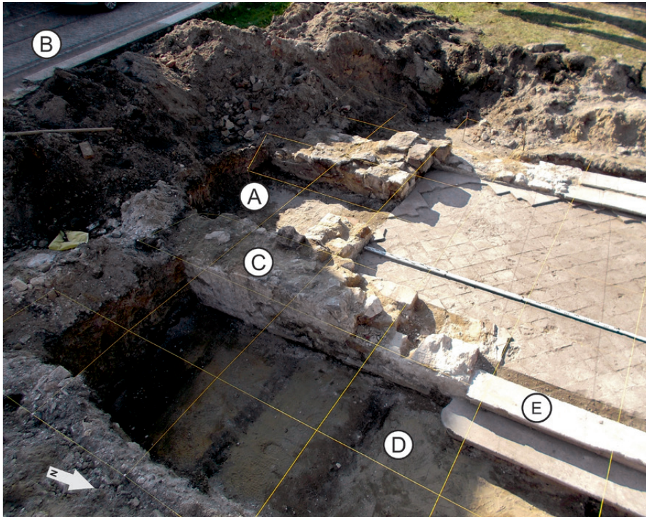
Ryc. 13. Olkusz, woj. małopolskie. Południowo-wschodnia partia odsłonięcia relikwów synagogi. Widoczne przejście do ul. Bóznicznej (A). W głębi po prawej stronie widoczny jest poziom współczesny ulicy Bóznicznej (B). Na pierwszym planie widać salę główną synagogi, otynkowaną ścianę zachodnią tej sali (C) oraz ślady po drewnianych legarach (D) pod podłogę. Na zdjęciu widoczne są również schody (E) prowadzące z głównej sali modlitewnej do usytuowanego na zachód od niej przedsionka (fot. D. Rozmus)
