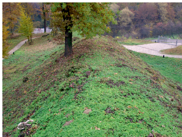
Ryc. 4. Trzcinińca, stan. 1, gm. Jasło, pow. Jasło, widok na drugie podgrodzie i wał zewnętrzny pierwszego podgrodzia (fot. Ł. Śpiewła)
