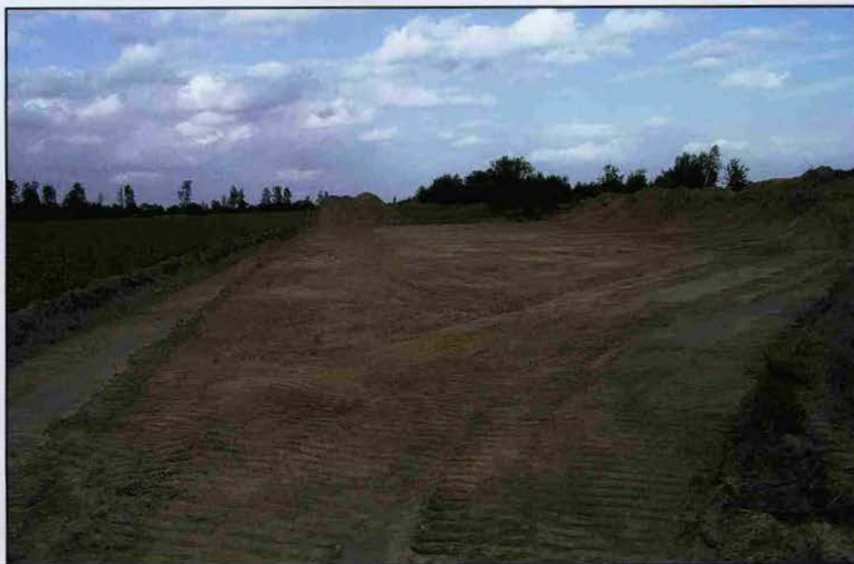
Ryc. 2. Nowa Wieś, stan. 3. Widok ogólny wykopu: a) po odczyszczeniu; b) po zdjęciu humusu przez spychacz (fot. Ł. Król).
