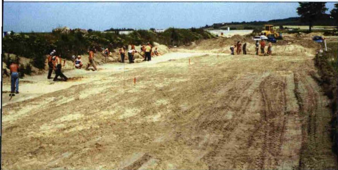
Ryc. 3. Zakrzów 6, pow. Krapkowice. Widok na wykop S od strony wschodniej. Fot. M. Masojć
